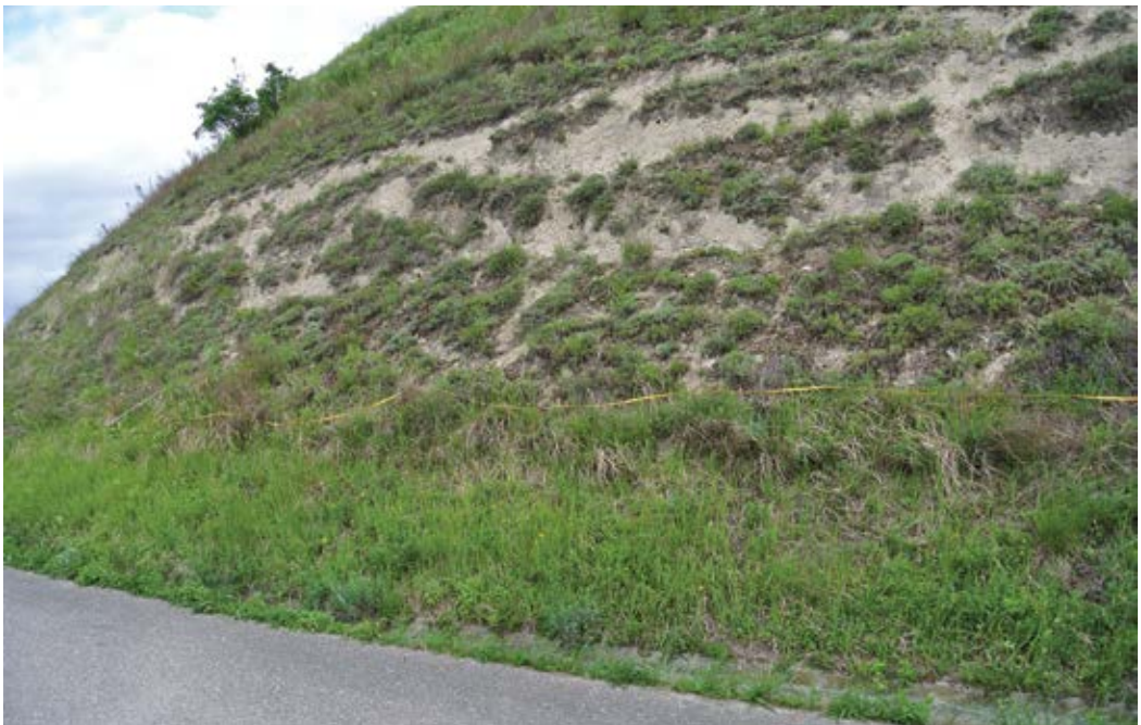
Abbildung 5: Untersuchte Böschung bei Ihringen im Abtsweingarten (Nr. 21, AS11) am 09.05.2014
